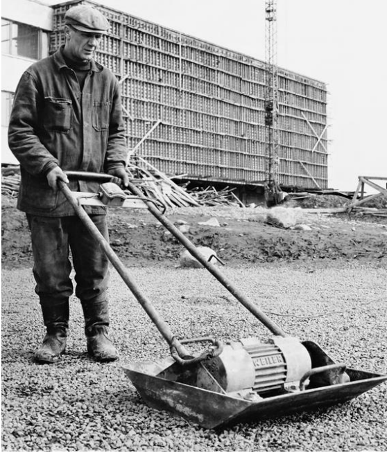
Maantiivistystä sähkökäyttöisellä tärylevyllä. (Ramirent Oyj:n kuva-arkisto)
